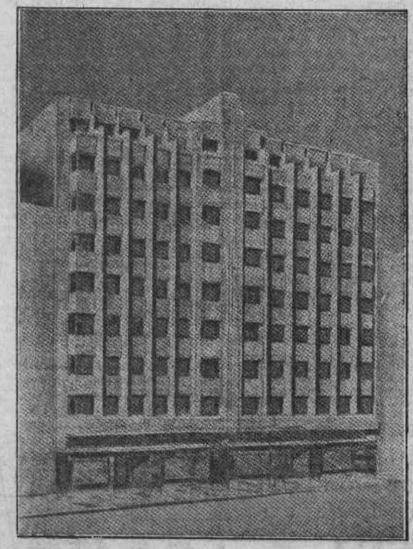
Edificio que se construye actualmente para la Previsión Social.
