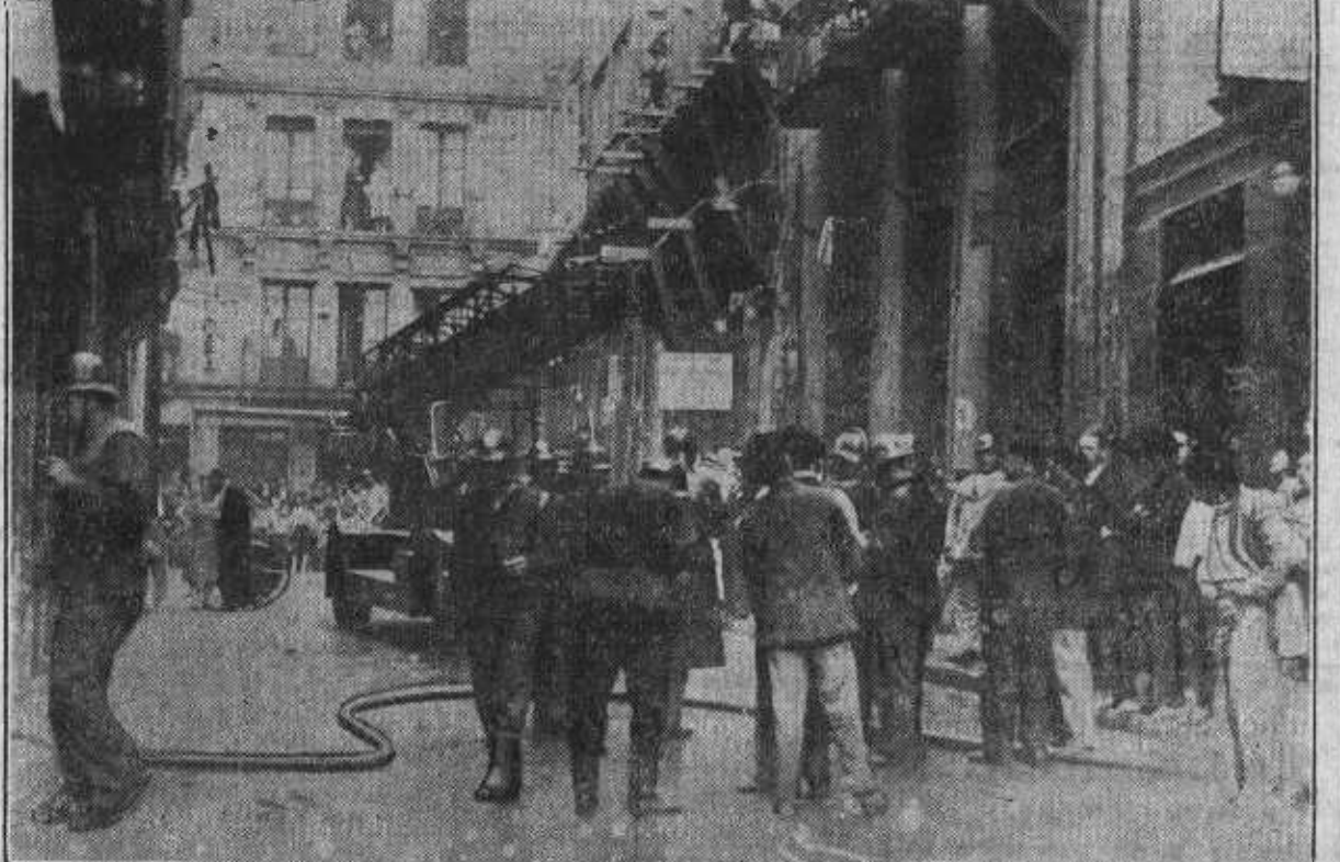
BILBAO. — Los bomberos sofocando el incendio que amenazaba destruir una casa de la calle de La Laguna.
