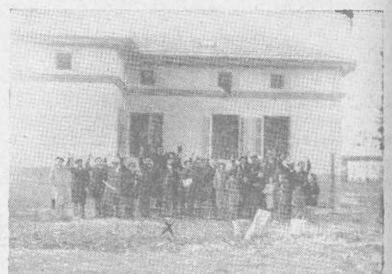
Chalet, a falta del cerramiento del jardín, construido al socio Fulgencio Díez, de Miranda de Ebro.
