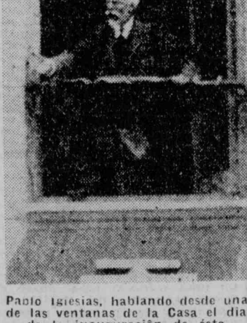
Pablo Iglesias, hablando desde una de las ventanas de la Casa el día de la inauguración de ésta
