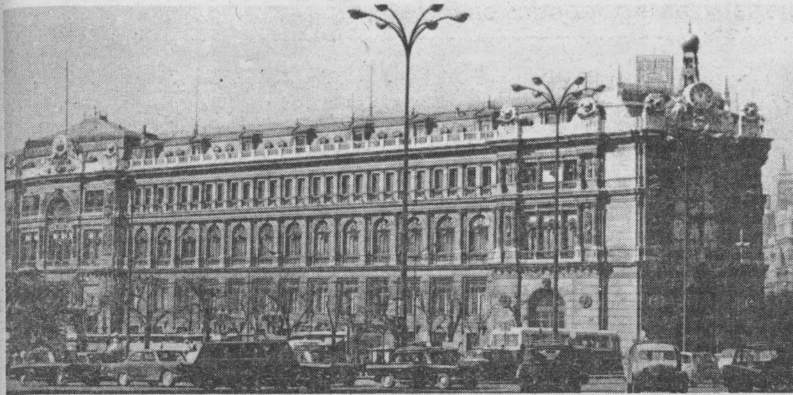
Fachada del Banco de España de Madrid
