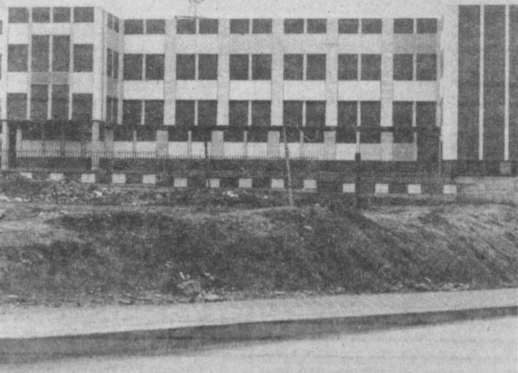
El nuevo colegio está acabado, pero de momento no se pueden dar clases
