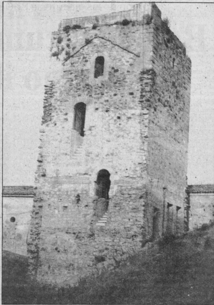
Torre de los Espaderos, junto a los escombros de la demolición
