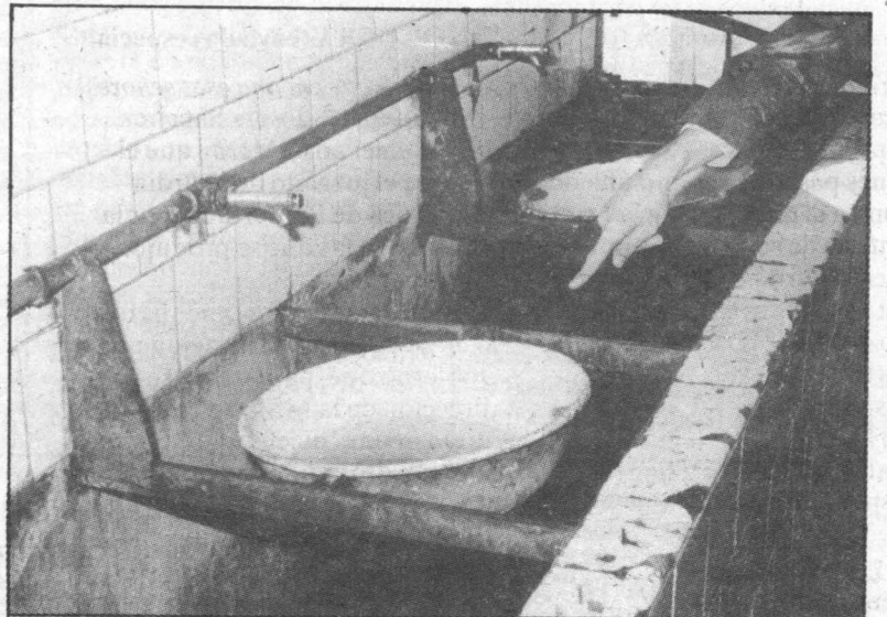
En los vestuarios del pozo María, ni lavabos ni agua caliente
