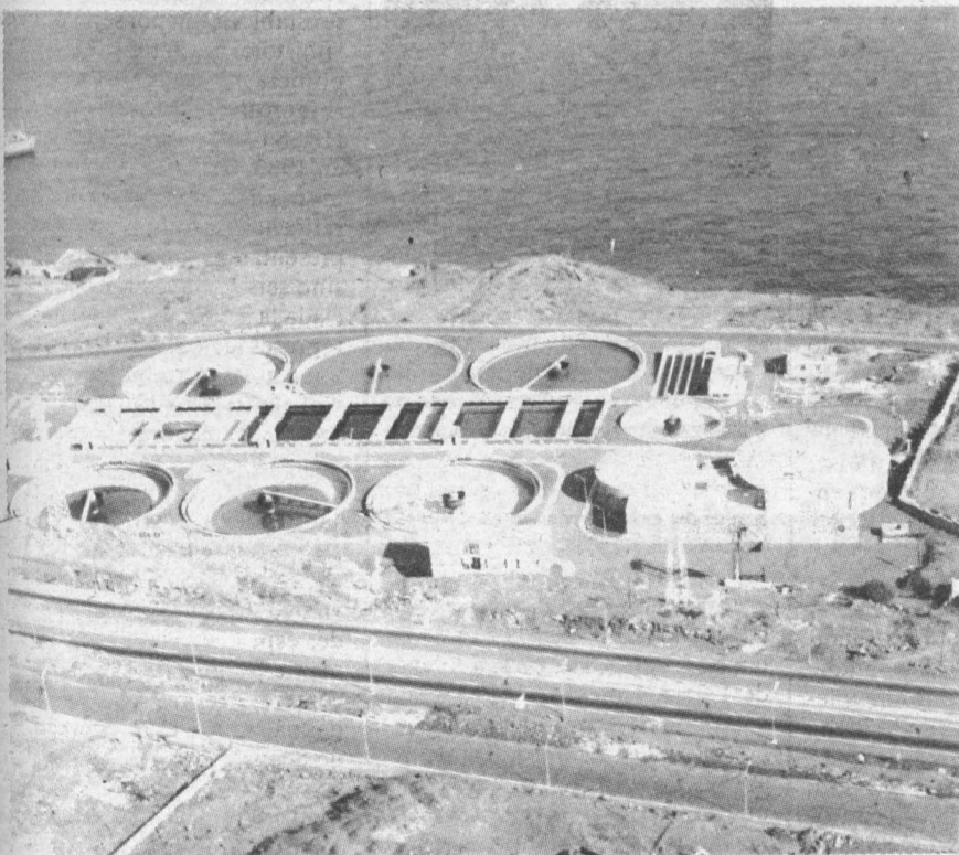
Depuradora de SANTA CRUZ DE TENERIFE Capacidad 90.000 m 3 /día.
