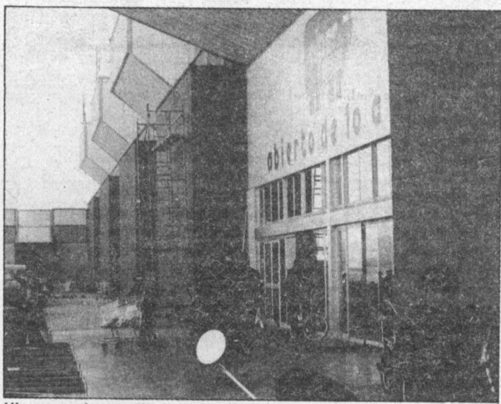
Hipergranada, un edificio prefabricado, clandestino e ilegal, a demoler
