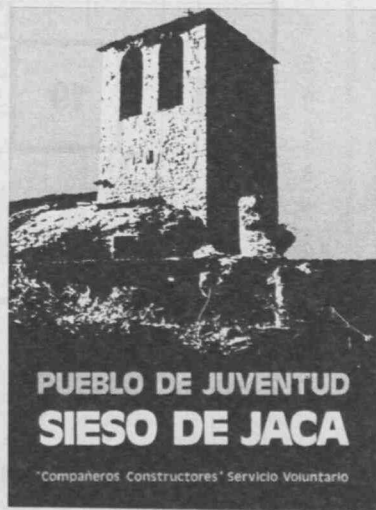
Los Compañeros Constructores se reúnen en Sieso de Jaca.
