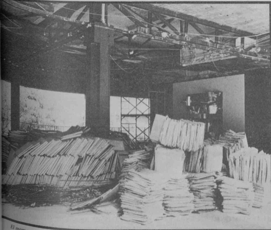
El momento de mayor peligro es cuando se desmontan los sistemas de aislamiento. La foto es del Museo de Arte Contemporáneo de Madrid. Cabe preguntarse si no habrá amianto en el edificio.
