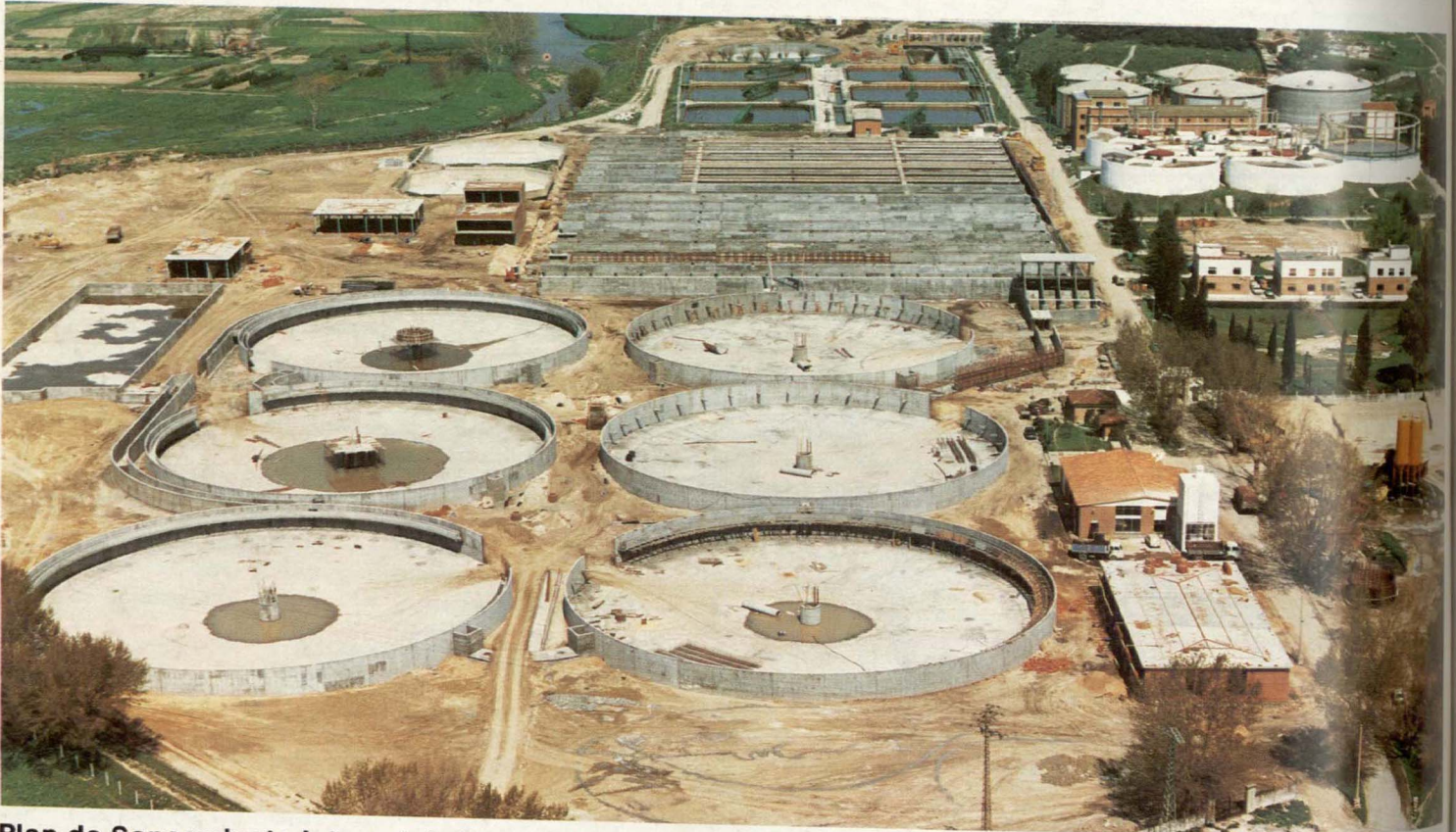
Plan de Saneamiento Integral de Madrid. Ampliación de la depuradora de «La China» (Madrid).
