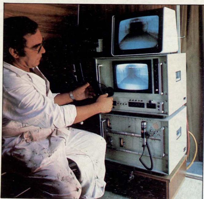
Inspección de redes de alcantarillado mediante circuito cerrado de televisión.
