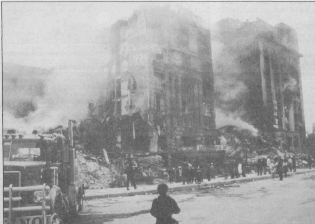
Las excavadoras derribaron los edificios que amenazaban con caerse tras el terremoto que sacudió la ciudad y destruyó la tercera parte de la misma.
