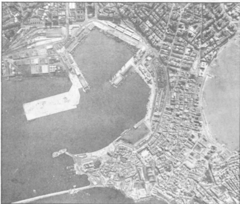
El Estado ha invertido 4.000 millones de pesetas en las transformaciones de la estructura portuaria coruñesa.
