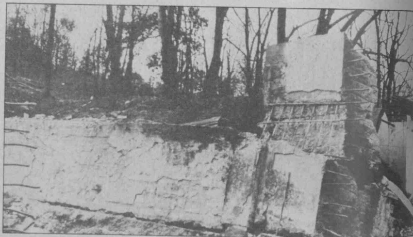
Los muros de hormigón de metro y medio de espesor fueron papel de fumar para 150 kilos de goma 2.
