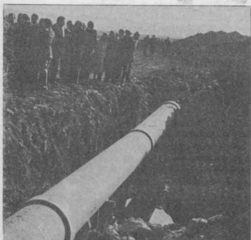
El saneamiento de «la sierra rica» de Madrid quedará completado en un año.
